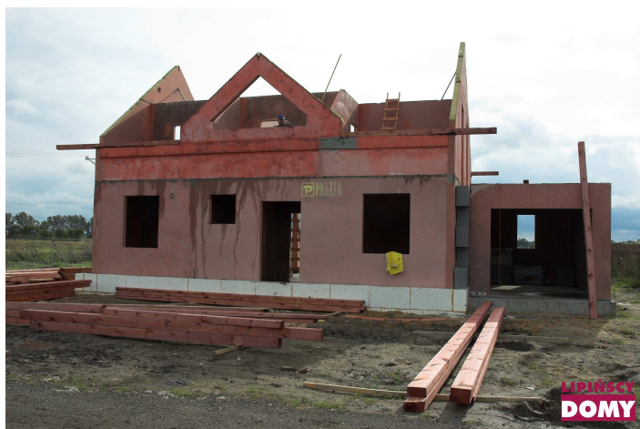
Rys. 3 Montaż prefabrykatów keramzytobetonowych.
