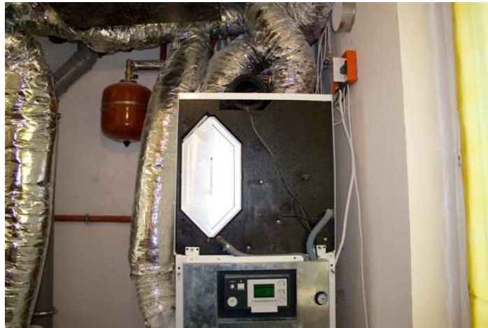
Rys. Zamontowane kompaktowe urządzenie grzewcze
