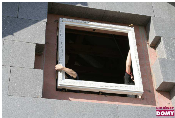
Rys. Montaż okien w domu pasywnym w warstwie izolacji zewnętrznej.
