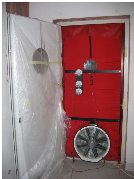
Rys. Test szczelności w domu pasywnym
