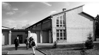
Budynek szkolny - przed modernizacją.
