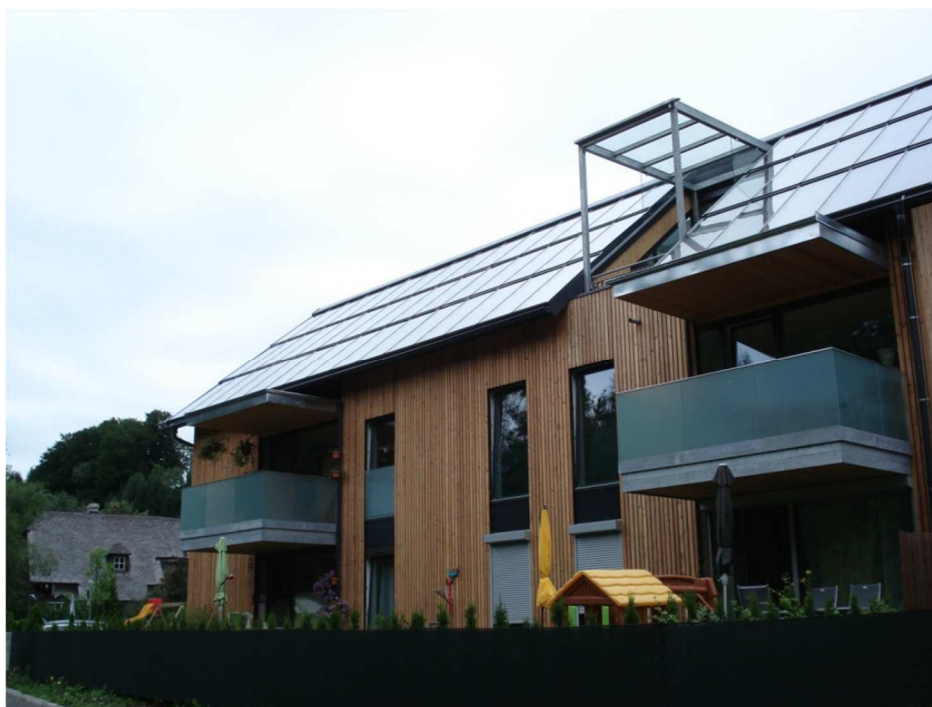
Rys.9 Kolektory słoneczne zintegrowane z dachem (Sonnenkraft) Austria
