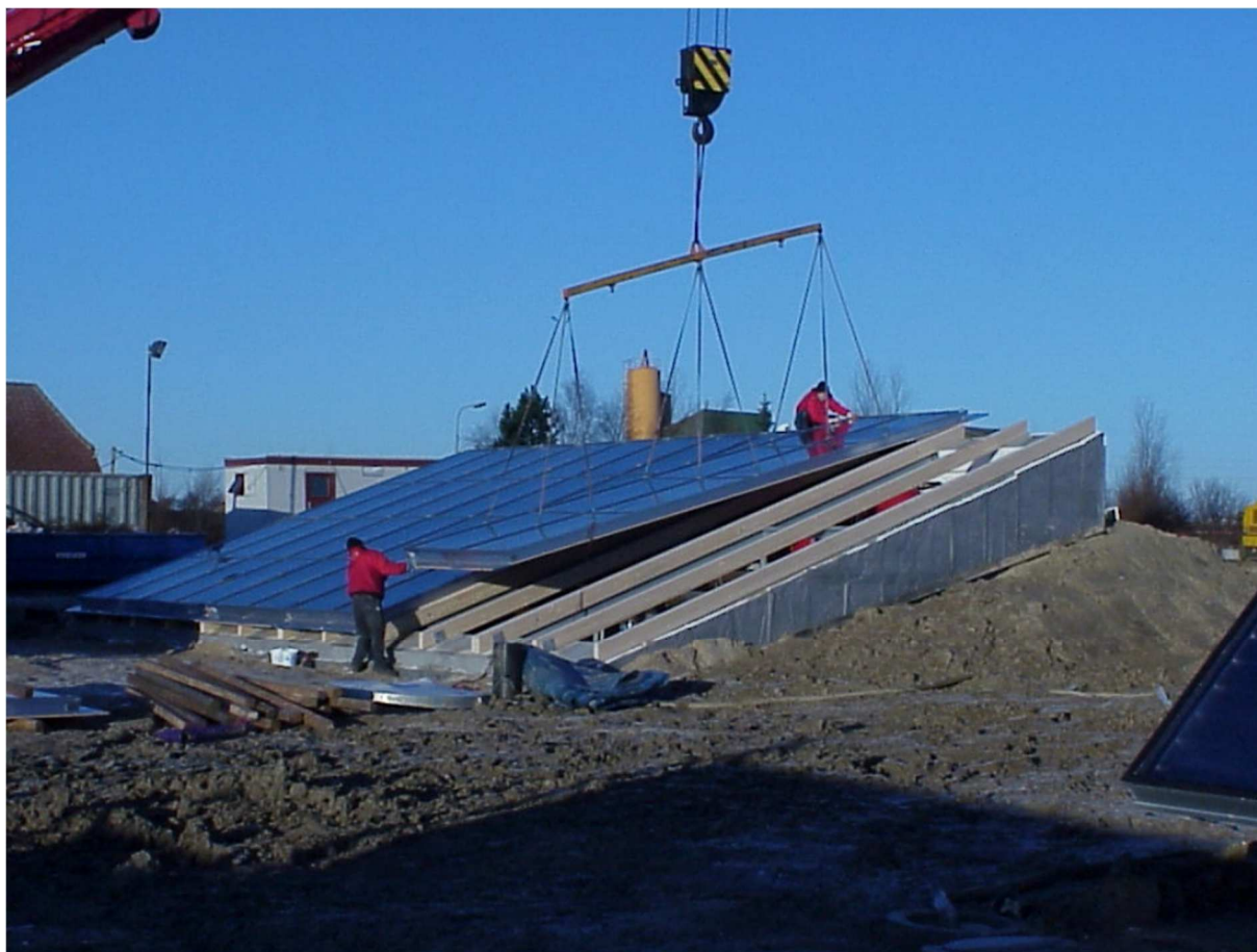
Rys. 8 Montaż modułów dachowych z kolektorów płaskich (Wagner), Marstal/Dania
