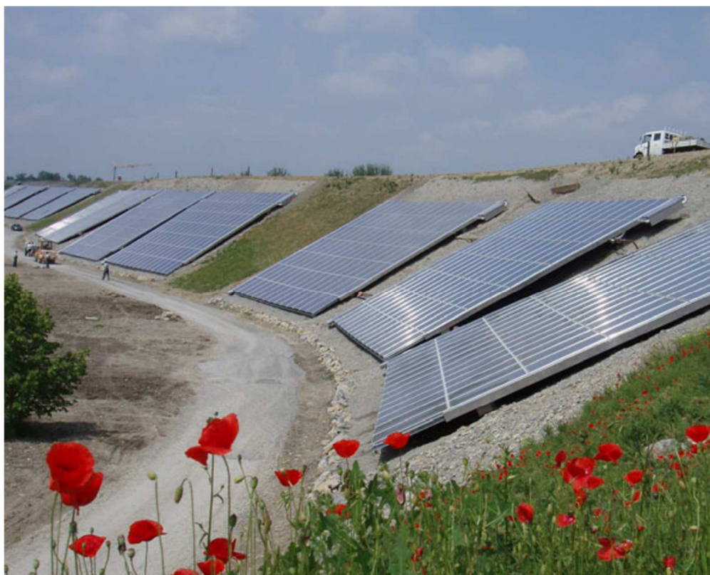
Rys. 11 Instalacja kolektorów na zboczu (Schüco), Crailsheim, Niemcy (źródło: Stadtwerke Crailsheim (Warto zwrócić uwagę na proporcje człowieka i samochodu do powierzchni kolektorów)
