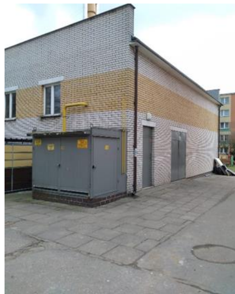
Budynek kotłowni osiedlowej
